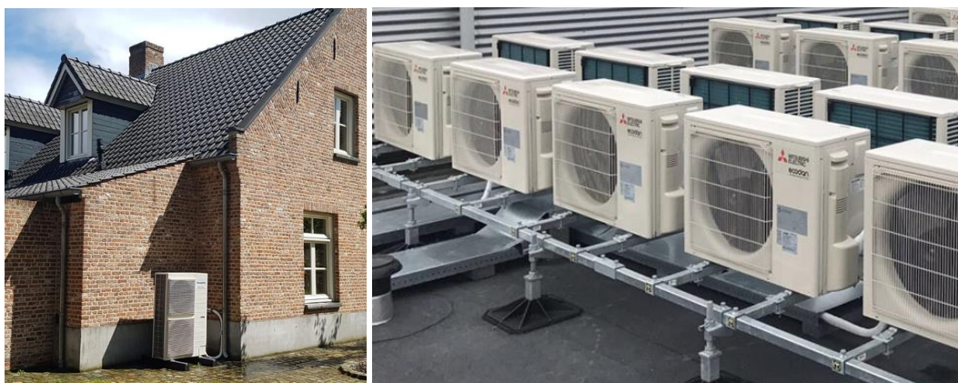
Figuur 7.3 | Voorbeeld buitenunit lucht-/waterwarmtepomp, enkele woning (links) of meerdere appartementen (rechts).
