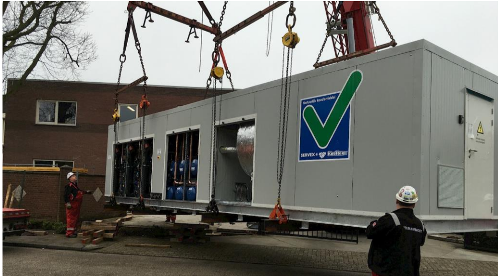
Figuur 7.10 | Plaatsing van een collectieve lucht-/waterwarmtepomp.
