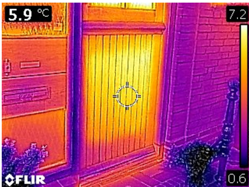
(houten onderdeel voordeur niet goed geïsoleerd, lek bij dorpel)
