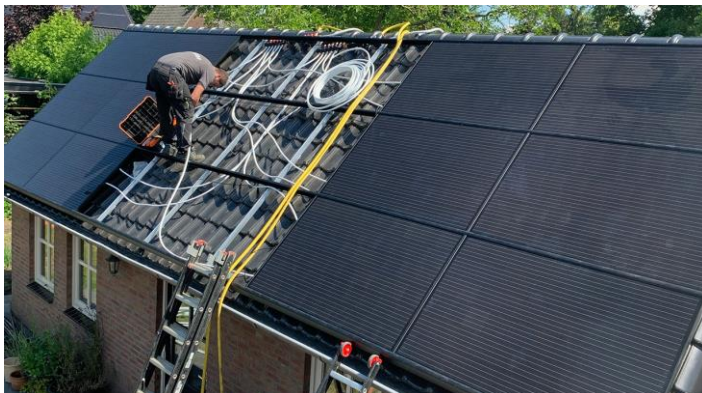
Figuur 7 - Plaatsen pvt-installatie
