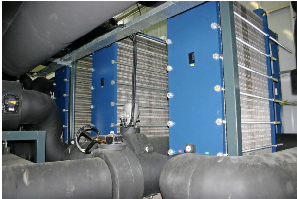
Figuur 14 - Aquathermie-uitkoppeling wisselt warmte uit met water ter regeneratie wko
